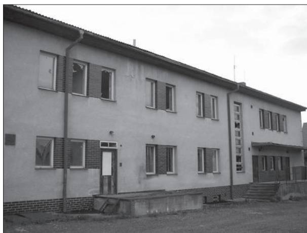
Obr. 13: Objekt původního kulturního domu v obci Zahrádky
