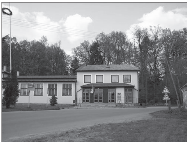
Obr. 11: Objekt původního kulturního domu v obci Budiškovice
