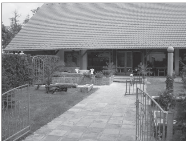
Obr. 10: Objekt původní prodejny Jednota v obci Majdalena
